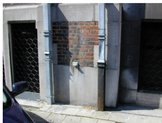
Figure 2.7 – Reprère altimétrique en fonte sur la façade du bâtiment du Dolez, rue de l'Alchimiste (document IGN).
