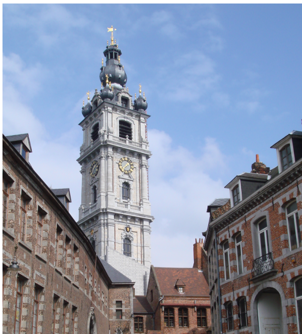
Figure 2.5 – Exemple de repère planimétrique élevé : beffroi de Mons. Le pied de la girouette au sommet de la tour sert de référence planimétrique ; le centre de la boule sert de référence altimétrique.
