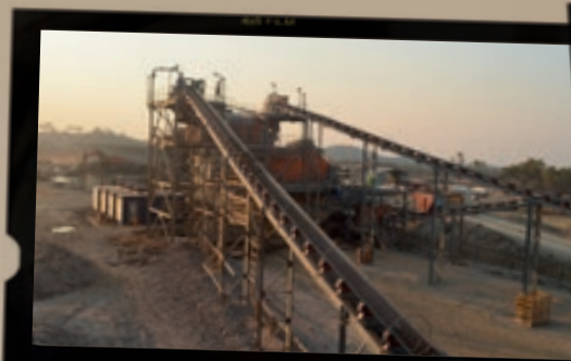
Unité de criblage et bandes transporteuses de l'usine de traitement du site minier de Kipoi Project (République Démocratique du Congo)
