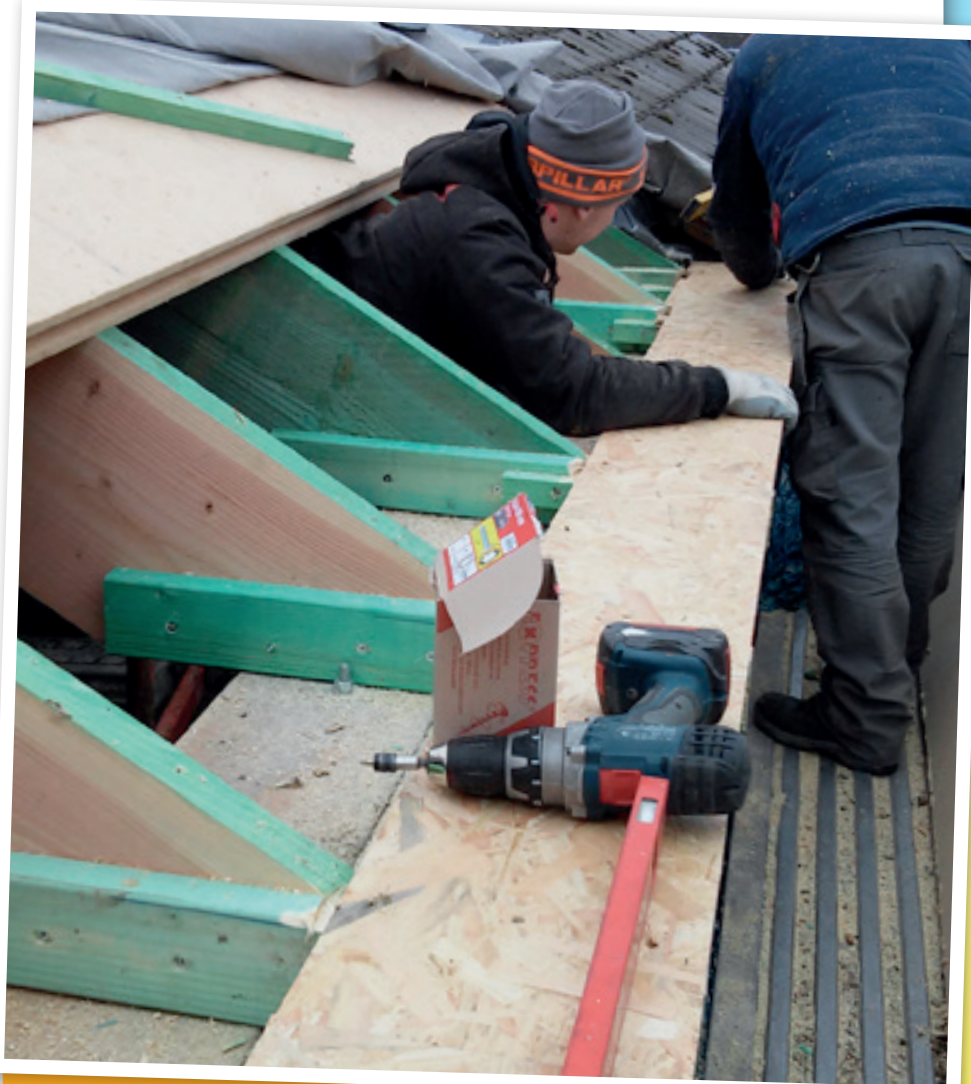
Le système « Sarking » est un procédé d'isolation thermique des toitures inclinées caractérisé par la pose de panneaux isolants rigides au-dessus des chevrons ou des fermettes. Les panneaux sont généralement en mousse synthétique ou en verre cellulaire, plus rarement en laine de roche rigide incompressible.
