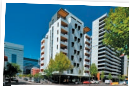
Forté building, premier immeuble à appartements en bois, de 32 m de haut, construit à Melbourne : 485 tonnes de bois transformé en Autriche et acheminé dans 29 containers.
