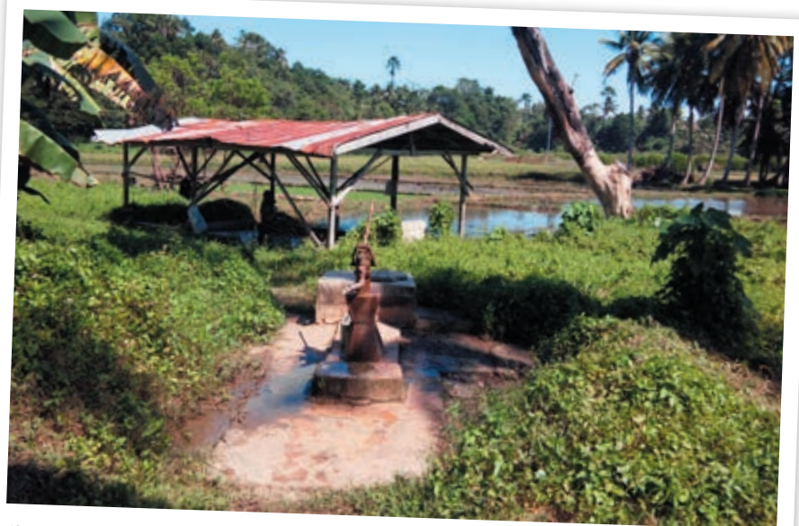
FIGURE 1 – Captage d'eau souterraine à proximité du village d'Opol (Philippines).
