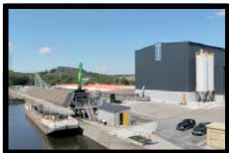
Déchargement des barges chargées de boues de dragage
