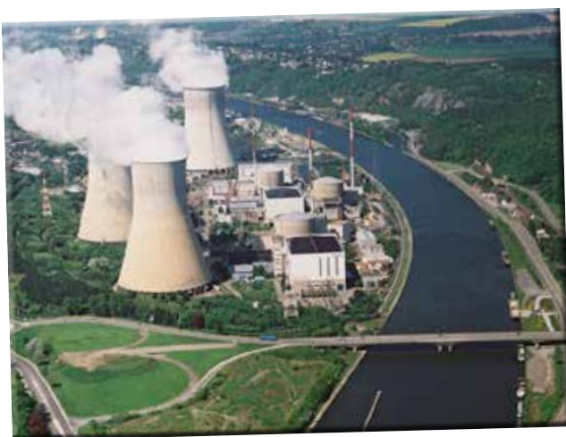
Centrale électrique de Tihange
