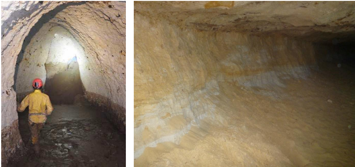
Figure 1 : Exemples de cavités typiquement rencontrées en Wallonie et dans les Hauts-de-France. (a) Carrière de craie de Hesbaye à Jauche-la-Marne (carrière de l'étang, photo SPW). (b) Carrière de sable dans la vallée de l'Aisne (photo Cerema).
