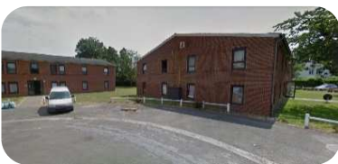
Figure 67. Blocs d'appartements à gabarit réduit à Épinlieu, bâtiments démolis depuis. @googlestreetview
