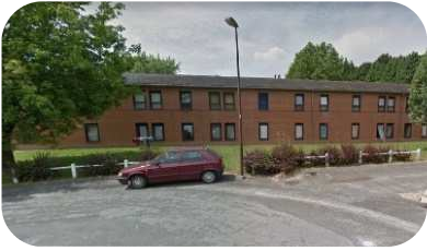
Figure 217. Anciens immeubles à appartements dits US d'Épinlieu et leurs jardins de devant de porte. @Googlestreetmap
