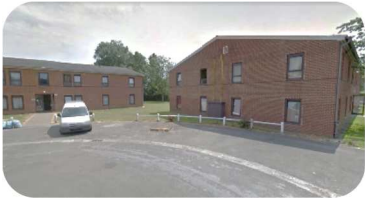
Figure 161. Ancien bloc d'appartement dits "US" démoli dans le quartier d'Épinlieu. @Googlestreetmap
