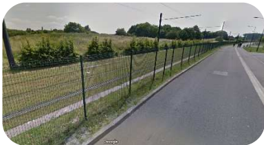
Figure 94. Tram en site protégé à Dutemple. @googleStreetView
