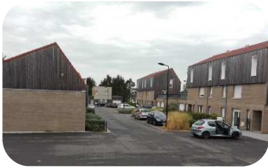
Figure 93. Logements rénovés à Dutemple. @projet RHS
