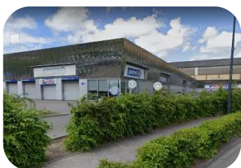
Figure 212. Surfaces commerciales à Denain. @googlestreetview, août 2019
