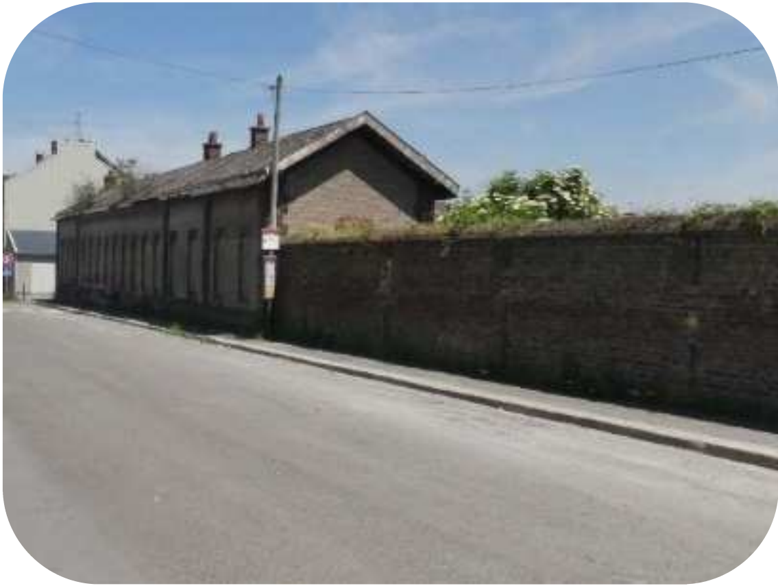
Figure 209. Mur d'enceinte d'Usinor marquant actuellement la limite du quartier du Nouveau Monde. @projet RHS
