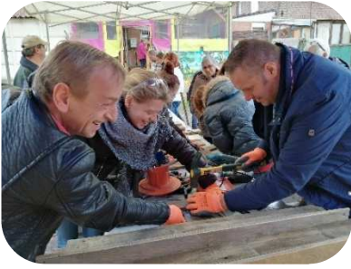
Figure 296. Atelier de construction en bois à Cuvinot. @projetRHS
