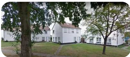
Figure 64. Cité du Parc du Bois de Mons, construite entre 1956 et 1958 par René Panis. @Googlestreetmap
