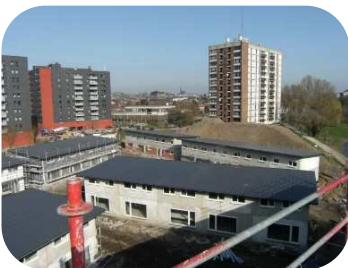
Figure 72. Quartier de l'Allée des oiseaux pendant les travaux de rénovation. A droite, une des tours datant des années 1970 et qui sera démolie ; à gauche les deux immeubles de la même époque rénovés, au premier plan, les maisons en construction. 2009, @ Vincent Piron
