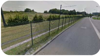
Figure 200. Tram en site protégé à Dutemple ©GoogleStreetView
