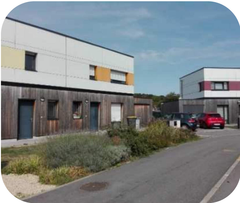
Figure 222. Dans les nouveaux logements, les jardins de devant de porte ont laissé la place à des accès piétons isolés de la voirie par un espace planté collectif. @projet RHS
