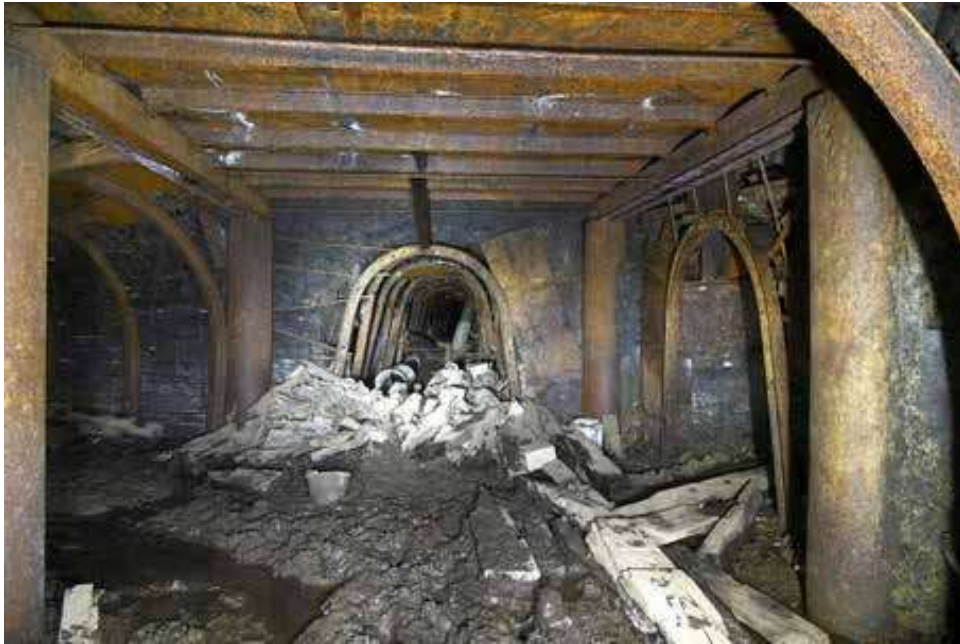
Figure 5. Vue intérieure du réseau de galeries de la Baraque à Ramons. La galerie principale, située au centre, a une longueur d'environ 75 m. Photo Edgar Bergstein, 2017.
