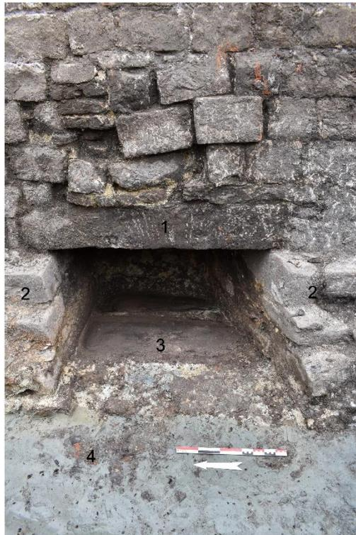
Figure 1 - Boussu : embouchure du conduit des latrines en façade ouest de la tour ouest du châtelet : 1. Linteau ; 2. Ressauts de fondation de la tour ; 3. Plancher en bois ; 4. Sable bleu naturel au fond des douves.
