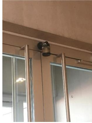
FIGURE 46 : Alarme signalant l'ouverture/la fermeture des portes, centre Fréminet, photo personnelle.
