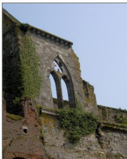
Fig. 1 - Abbaye d'Aulne. Fissures apparues dans le mur O du transept N après les restaurations au mortier «de ciment» au début du XXème s. (Photo J. Snaet, Régie des bâtiments)
