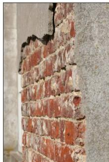
Fig. 2 - Divers exemples de pathologies dans les maçonneries : décollement des mortiers et enduits, fissurations. (Photos M. Demelenne - J.-C. Scaillet)
